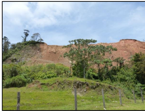
Fotografía 4. Mina o cantera ubicada en la autopista Medellín-Bogotá en límites con el DRMI Sistema Viaho Guayabal.
