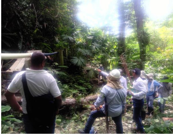
Fotografía 48. Visita en campo de las obras del acueducto y la zona de posible construcción de la PTAP
